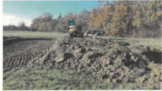
Décapage site récepteur
