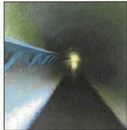
Exemple de banquette en encorbellement dans un ouvrage de type buse – Source : Guide Permettre à la faune de franchir les infrastructures linéaires de transport, CEREMA, 2019
