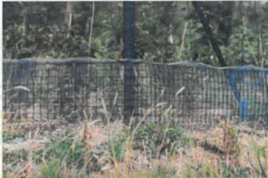
Figure 31 : Treillis soudé à mailles fines adossé à une clôture à grandes mailles, avec la partie supérieure recourbée et la partie inférieure enterrée – Source : Biotope en haut et J. Carsignol, SETRA 2008 en bas
