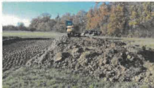
Décapage site récepteur
