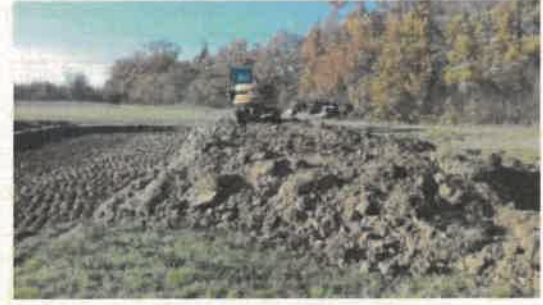
Décapage site récepteur
