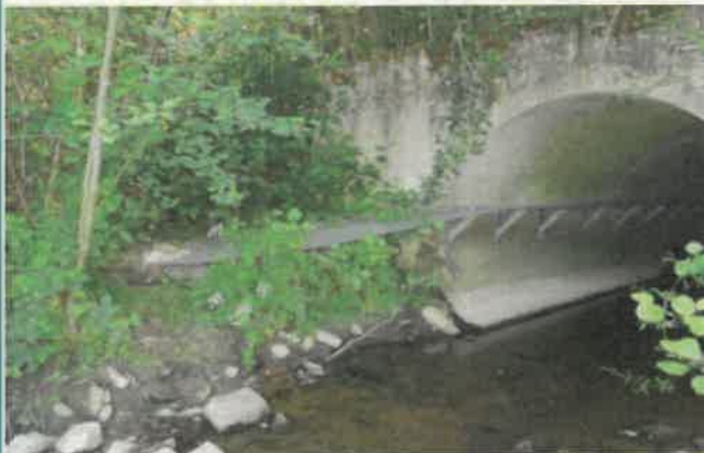
Exemple de banquette en encorbellement dans un ouvrage de type buse – Source : Guide Permettre à la faune de franchir les infrastructures linéaires de transport, CEREMA, 2019
