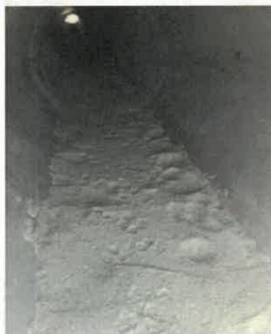
Figure 27 : exemple de mise en place d'un substrat naturel dans un ouvrage petite faune - Source : Guide CEREMA « Permettre à la faune de franchir les infrastructures linéaires de transport », 2019
