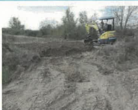
Dépôt de la terre sur le site récepteur
