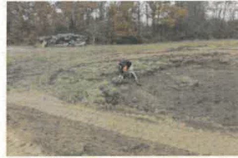
Positionnement et jointage des mottes sur le site récepteur
